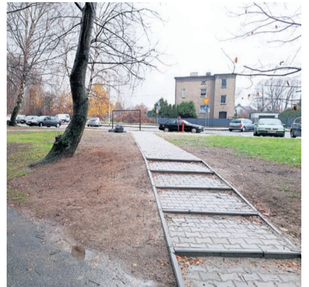
Remont przejścia na parking w rejonie budynków Radockiego 248-250.
