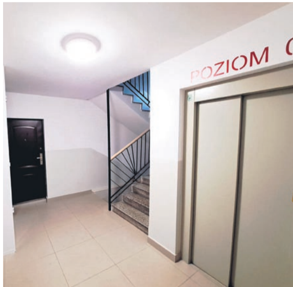
Malowanie klatki schodowej wraz z robotami towarzyszącymi w budynku przy ul. Radockiego 200.
