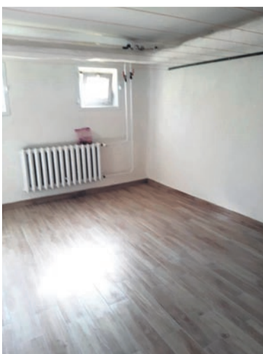
Remont suszarni w budynku przy ul. Targowej 9a.
