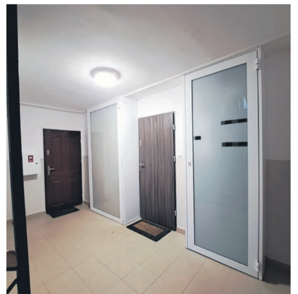
Malowanie klatki schodowej wraz z robotami towarzyszącymi w budynku przy ul. Radockiego 198
