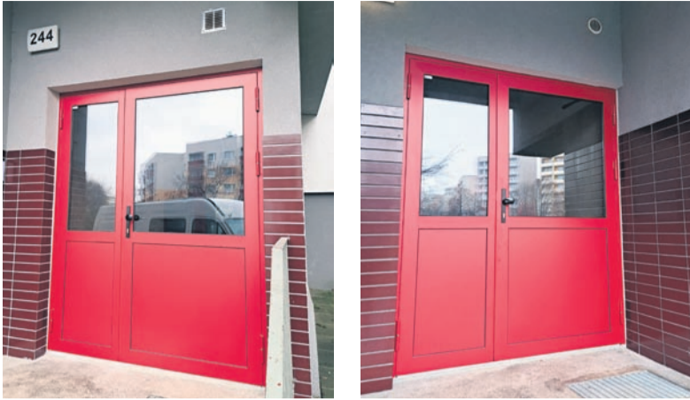
Wymiana drzwi wejściowych w budynku przy ul. Radockiego 244 i ul. Radockiego 274.
