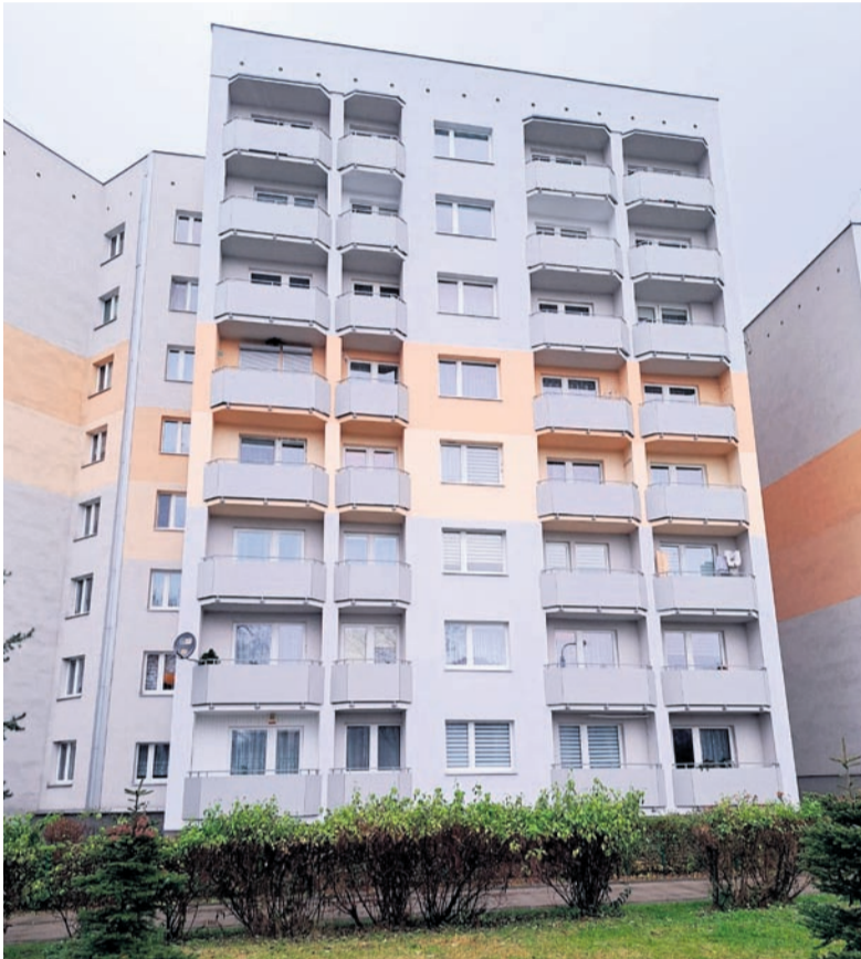
Remont balkonów w budynku przy ul. Radockiego 172.
