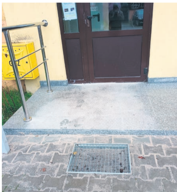
Remont podestu przy ul. Szewskiej 4a.
