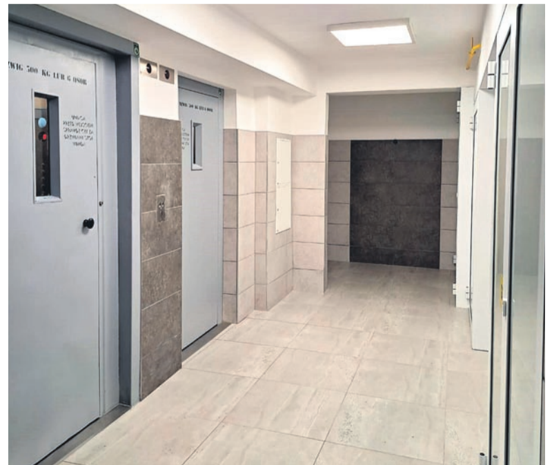
Remont parteru klatki schodowej – ul. Radockiego 152.
