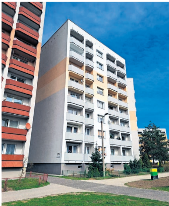
Remont balkonów – ul. Radockiego 174.
