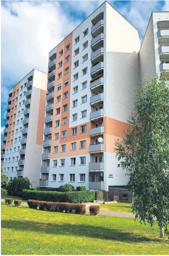
Wyremontowane balkony w budynkach przy ul. Radockiego 244 i 246.
