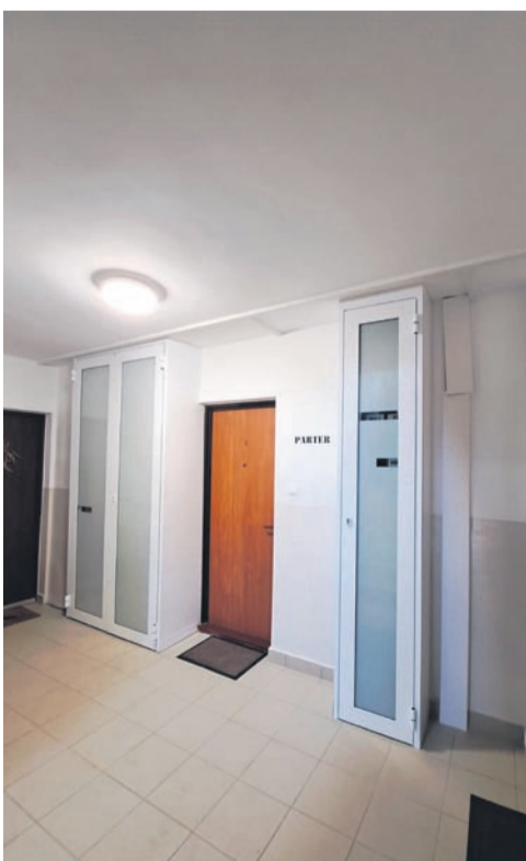
Pomalowana klatka schodowa w budynku przy ul. Radockiego 204.
