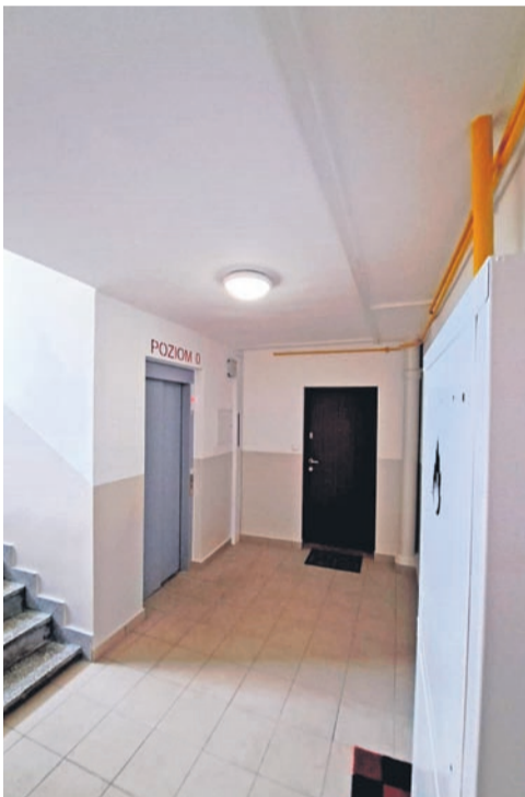
Pomalowana klatka schodowa w budynku przy ul. Łętowskiego 8.
