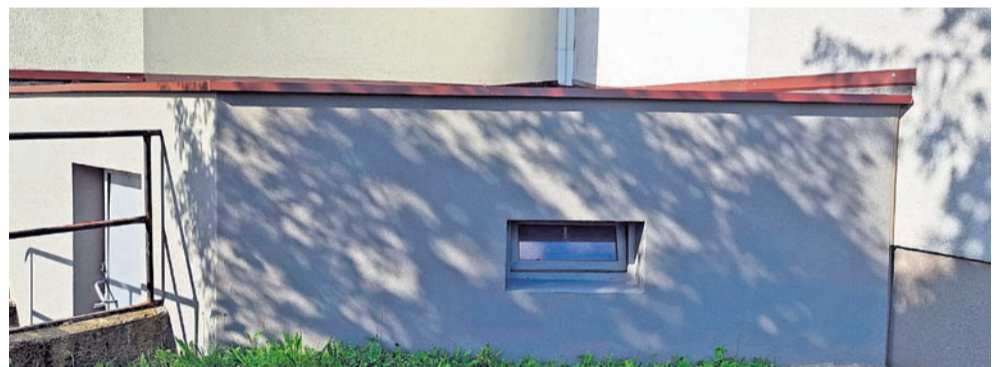
Wyremontowane elewacje przewiązek pomiędzy budynkami przy ul. Radockiego 86-88, 88-90 i 104-106.
