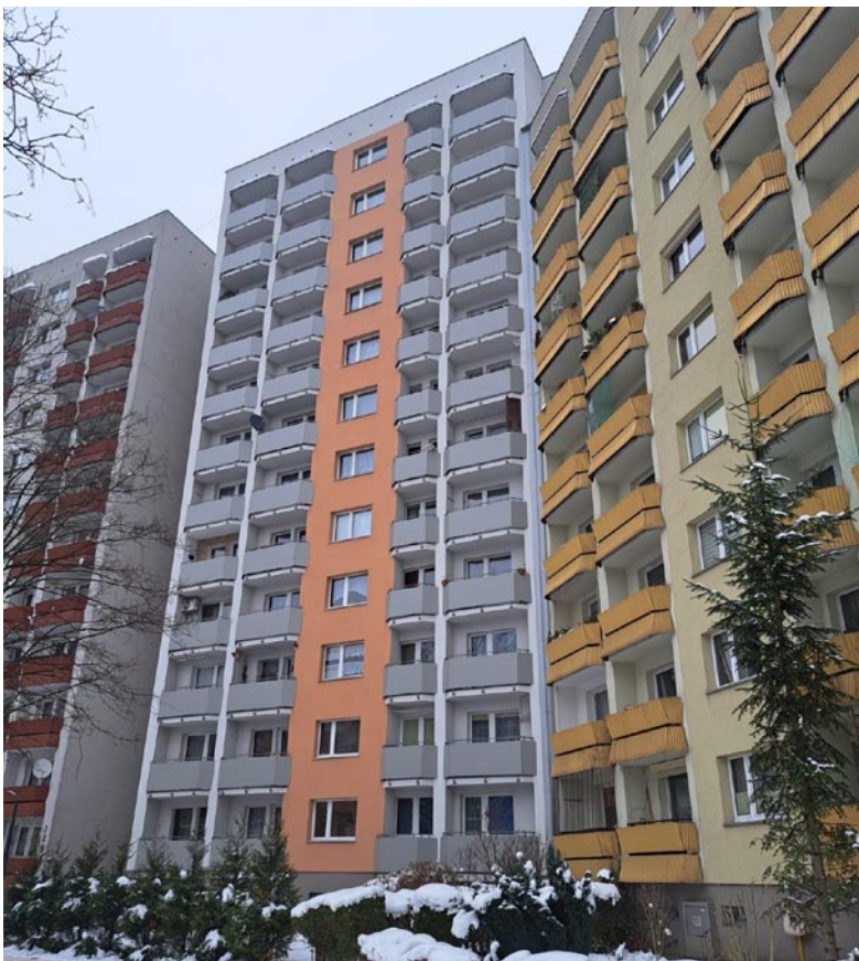
Kompleksowo odnowione balkony budynku przy ul. Radockiego 128.
