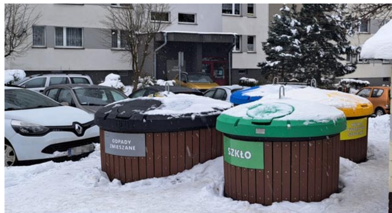
Nowo wybudowane pojemniki półpodziemne do selektywnej zbiórki odpadów przy ul. Radockiego 68.
