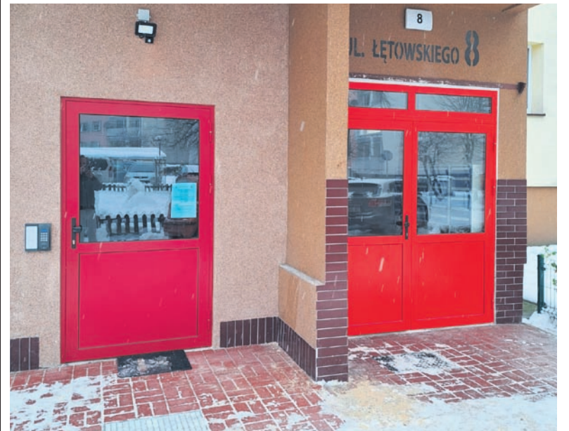
Po zakończeniu zaplanowanych prac remontowych w 2024 r. na osiedlu Odrodzenie będzie zmodernizowanych już 40% wind.
