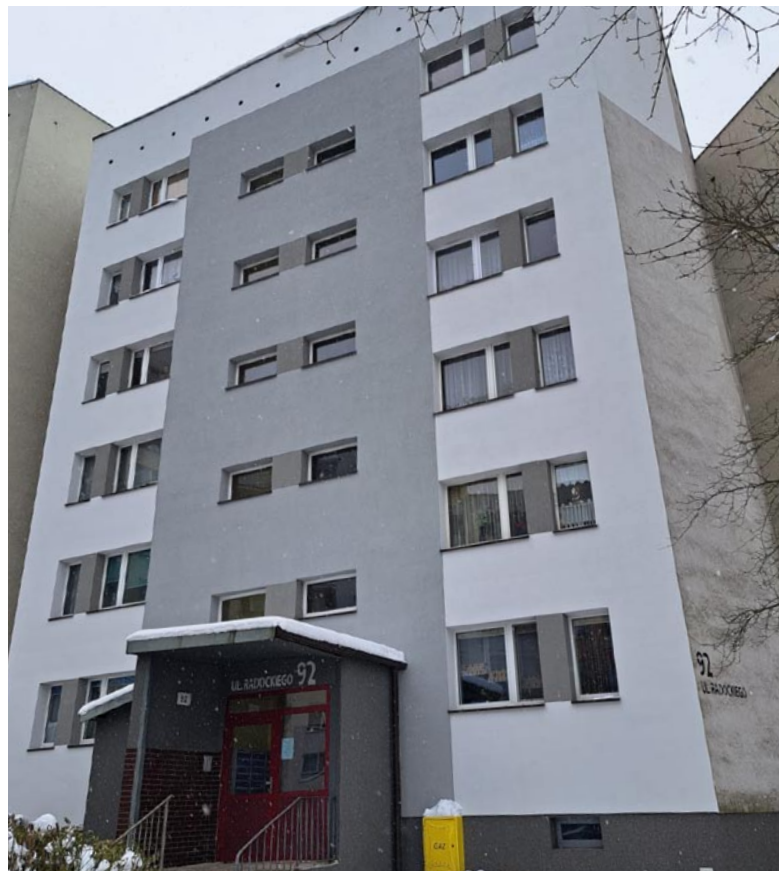
Czyszczenie wraz z malowaniem elewacji budynku przy ul. Radockiego 92.
