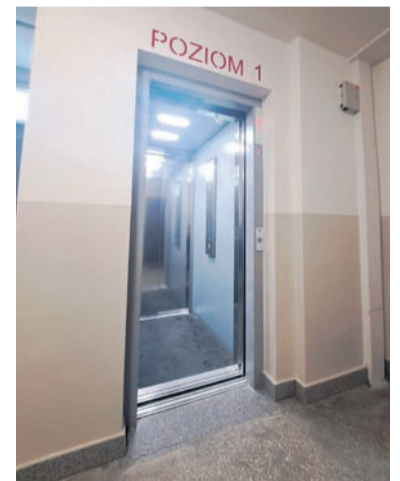
Wymiana windy wraz z wybudowaniem dodatkowego przystanku na poziomie ciągu pieszo-jezdnego w budynkach przy ul. Radockiego 246 i 248.
