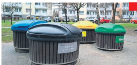
Montaż pojemników półpodziemnych do selektywnej zbiórki odpadów przy ul. Radockiego 110...
