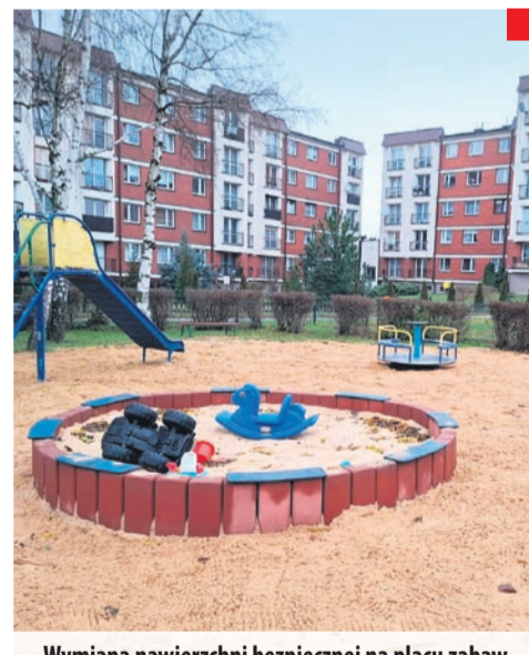
Wymiana nawierzchni bezpiecznej na placu zabaw w rejonie ul. Spokojnej i Radockiego.
